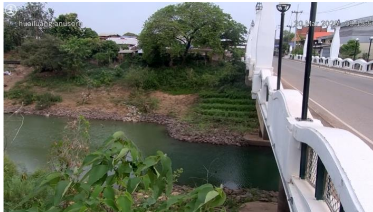
C031703 : สะพานห้วยหลวงอนุสรณ์ ต.จุมพล อ.โพธิ์พิสัย จ.หนองคาย
